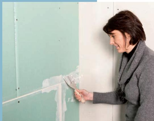
L'application de l'enduit Knauf Uniflott, recommandée et éprouvée, garantit des finitions parfaites et soignées pour des cloisons prêtes à peindre, sans surépaisseur.
